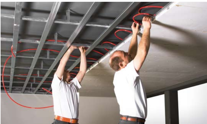
Mittels Presskupplungen erfolgt die Verbindung der Rohre. Diese sind einfach, sicher und schnell mit der Pressgun 4B verpresst.
