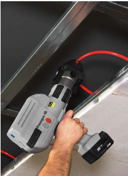
Mittels Presskupplungen erfolgt die Verbindung der Rohre. Diese sind einfach, sicher und schnell mit der Pressgun 4B verpresst.
