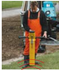
Bohrlanze mit Sender.
